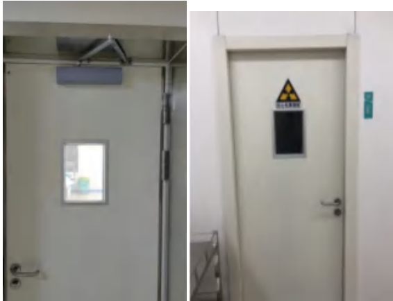
东侧走廊防护门、工作状态指示灯、电离辐射警告标志
