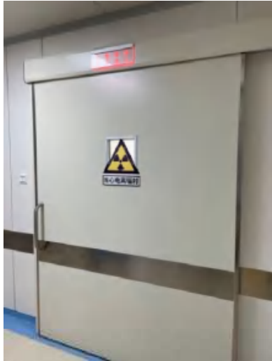
东侧走廊防护门、工作状态指示灯、电离辐射警告标志
